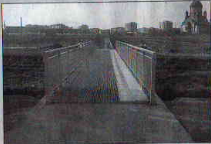
Híd a Pece fölött. A napokban készült el a a Pece patakra tervezett több gyalogátjáró híd egyike, mely az Erkel Ferenc utcából könnyíti meg a patakon való átkelést a Pece bal partján épülő szabadidőközponthoz.
